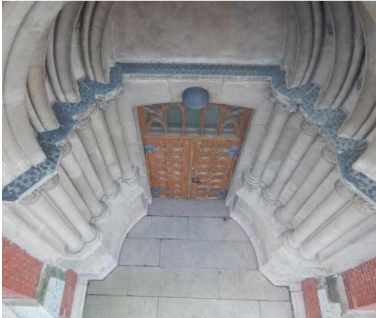
Suojaisimmat betonipinnat ovat säilyneet kohtalaisen hyväkuntoisina.
