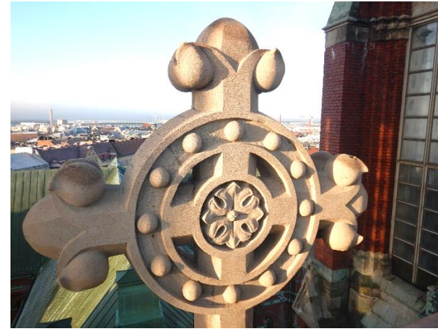
Pintahalkeilua yläosan ristissä, joka on uusittu 90-luvulla.
