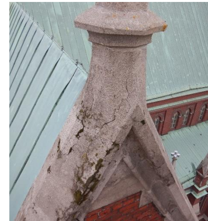
Halkeamia ja leväkasvustoa kärki-kolmion alueella.
