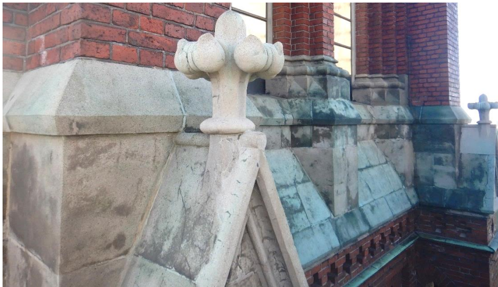
Nurkkapilastereiden kolmioiden etureunat ja koristekukat ovat kohtalaisen hyvin säilyneitä. Paikkakorjauksen rajapinta erottuu selvästi.
