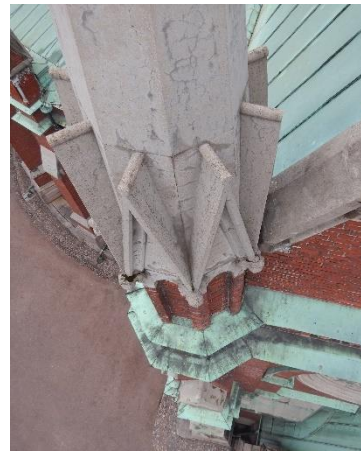
Halkeamia todennäköisesti korjatun osan betonipinnassa.
