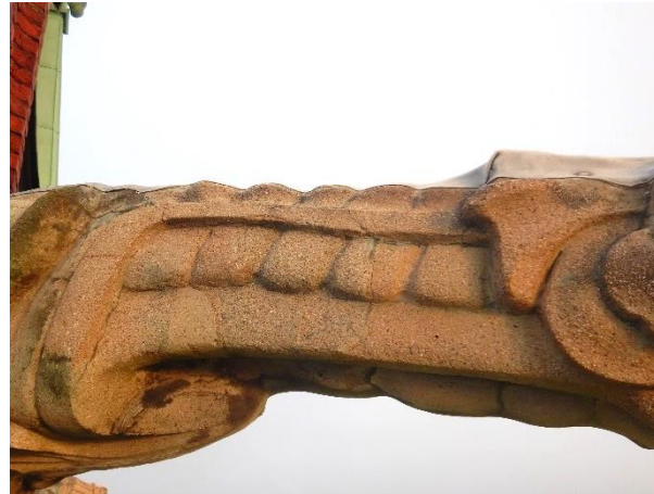
Kiviaines on peseytynyt esiin gargoilin betonipinnassa. Halkeama gargoilin kaulassa, todennäköisesti korjaustyösauman kohdalla.
