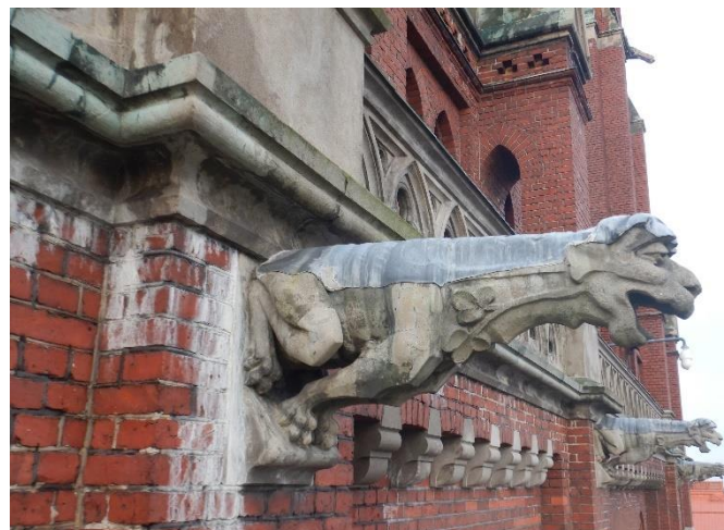
Muuraussaumamat ovat paikoitellen rapautuneet pinta-kerroksestaan parvekkeen alapuolisella julkisivuosalla rakennuksen kaakkoisnurkalla.
