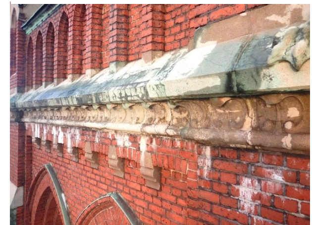
Kalkkivalumaa tiilijulkisivussa. Betoninauhassa ei ole tippauraa, joka estäisi sadeveden valumisen nauhan alapuolisille koristeosille sekä julkisivupinnalle.
